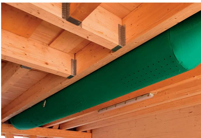
Textiles Luftverteilsystem luftdurchlässig mit Microperforation oder Textildüsen aus 100% Polyester. Schwer entflammbar. Formstabiler Endboden und einseitigem Easy Clip Seilsystem für die Aufhängung. Das System ist einfach erweiterbar.
